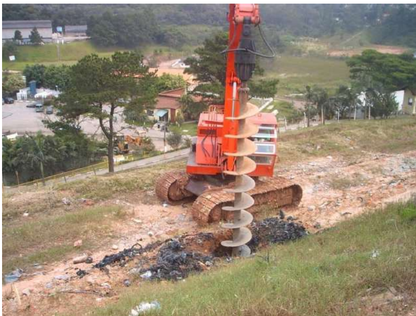
Figura 16 Perfuração no aterro sanitário Lara. - Fonte: LARA, 2008.
