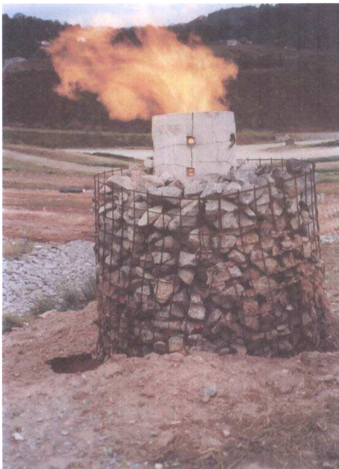
Figura 19 Vista do Dreno Vertical Queimando Biogás
