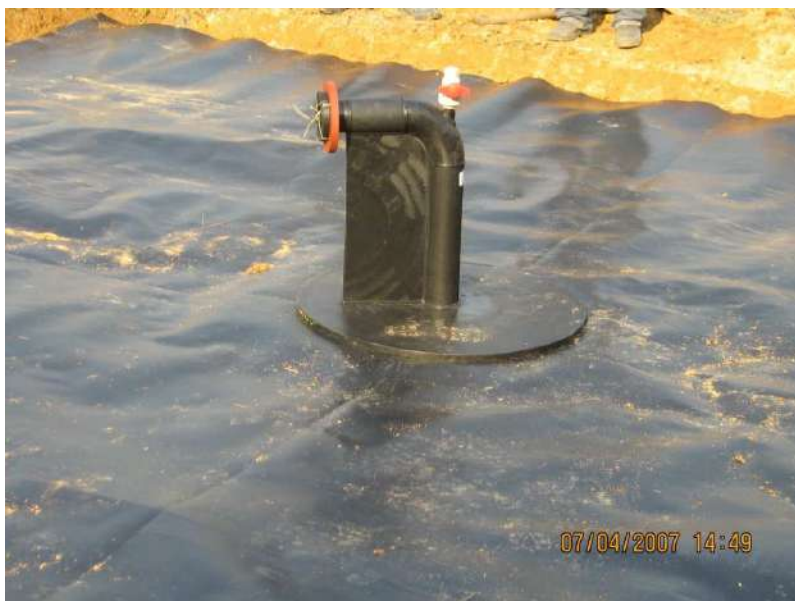
Figura 41 Vista de instalação de cabeçote no Aterro Sanitário Terrestre.
