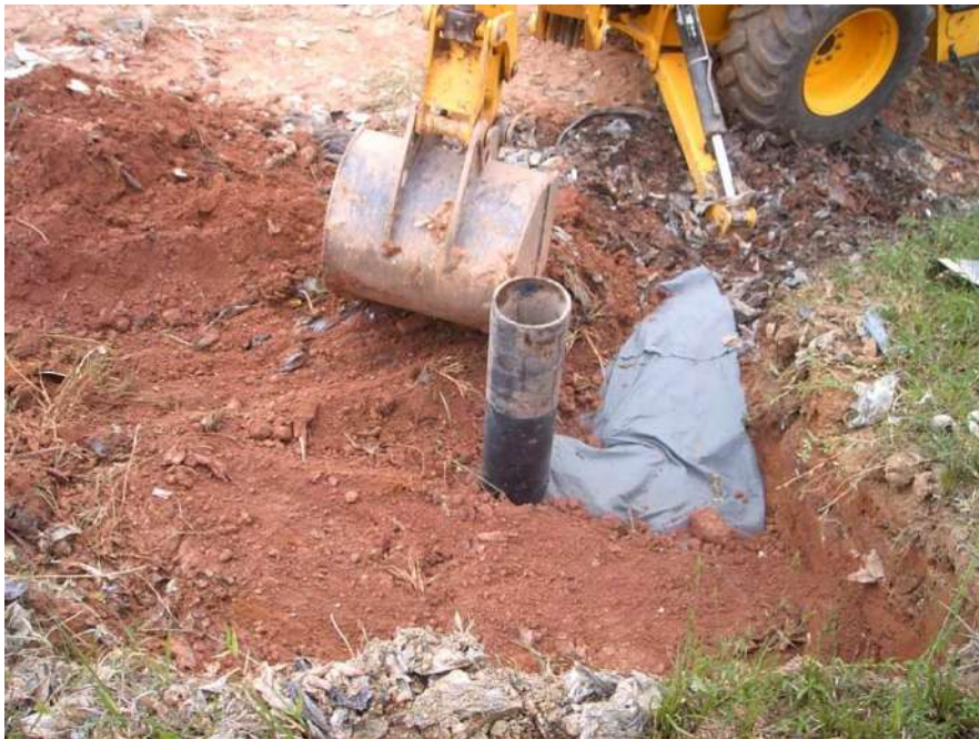
Figura 36 Vista de execução de camada protetora.
