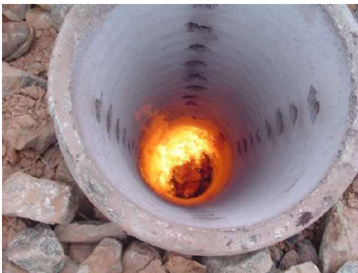
Figura 28 Vista de dreno vertical com fogo.
