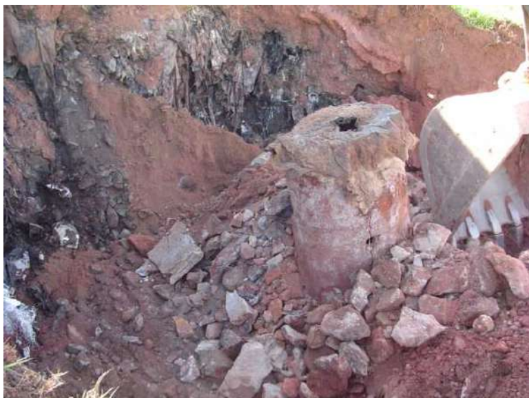
Figura 34 Vista de escavação de dreno vertical.
