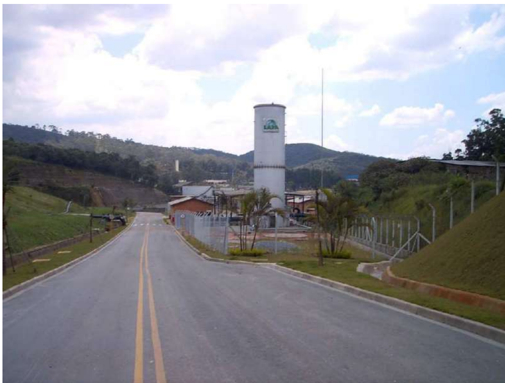
Figura 46 Vista da Usina de Combustão (Flare) de Biogás no Aterro Sanitário Lara.
