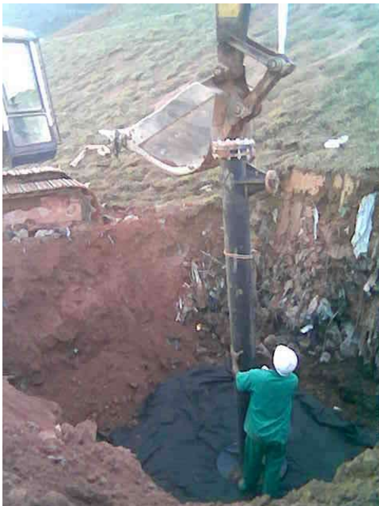
Figura 42 Vista de instalação de cabeçote no Aterro Sanitário CDR-Pedreira.
