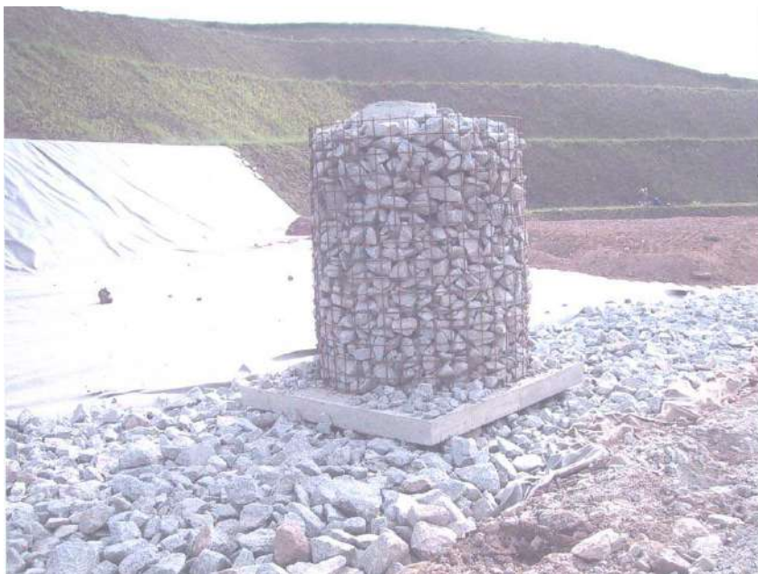
Figura 44 Dreno vertical (PDR) . Fonte: Delbin, 2004.
