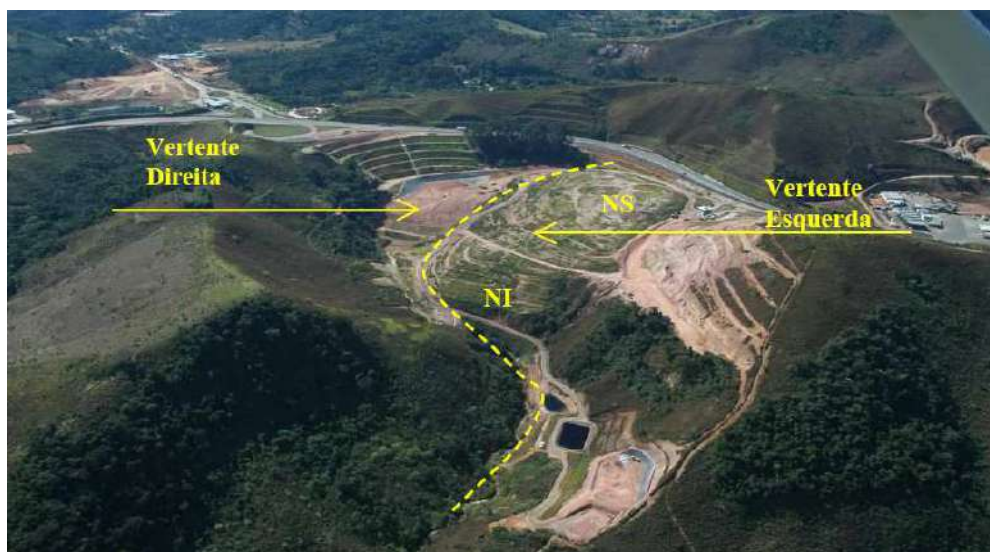
Figura 3 Visão aérea do aterro sanitário Salvaterra (2006).
