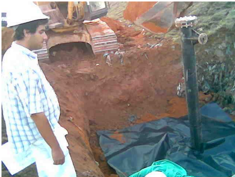
Figura 37 Vista de instalação de Manta PEAD em talude.
