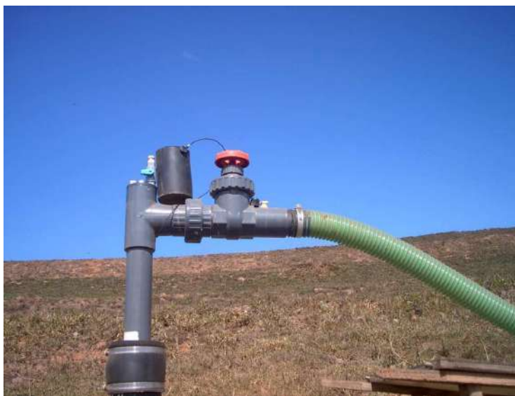
Figura 45 Vista de cabeçote em teste no Aterro Sanitário LARA.
