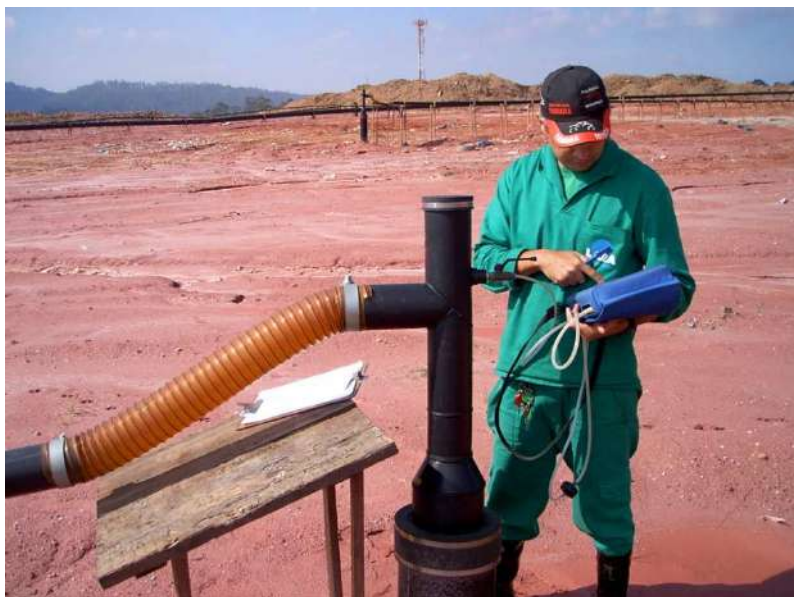
Figura 447 Vista de cabeçote instalado no Aterro Sanitário LARA.
