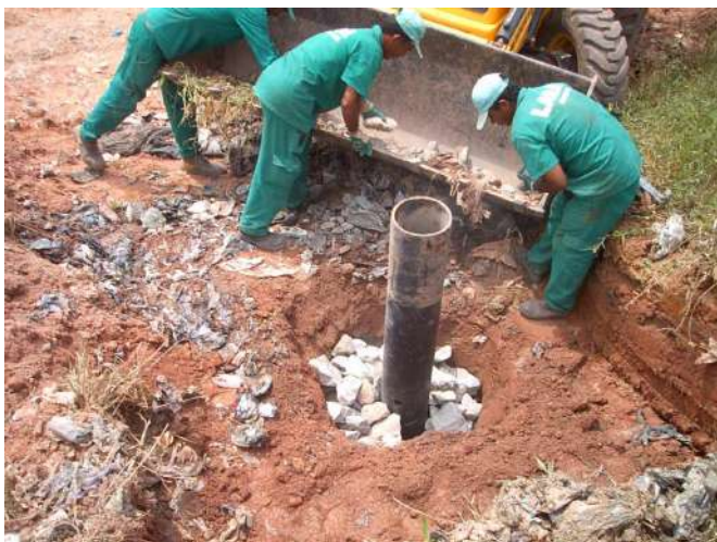
Figura 17 Execução de Dreno no aterro sanitário Lara. - Fonte: LARA, 2008.
