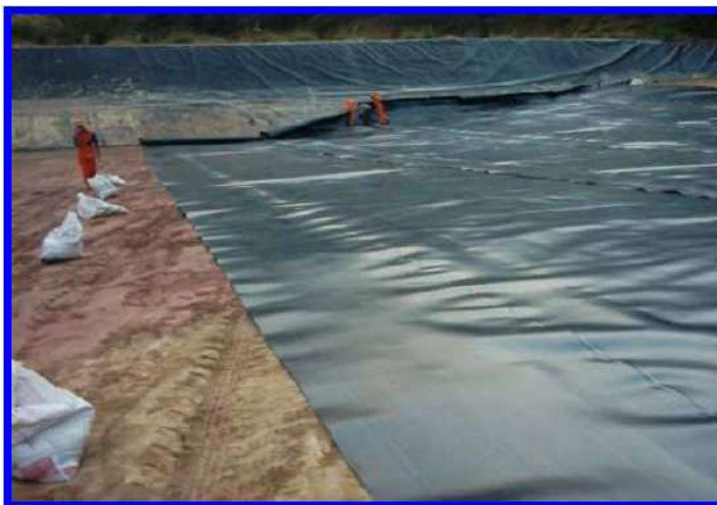
Figura 2 Instalação com manta de impermeabilização PEAD 2mm.
