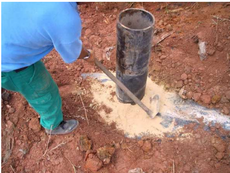
Figura 39 Vista de execução de selo com bentonita.
