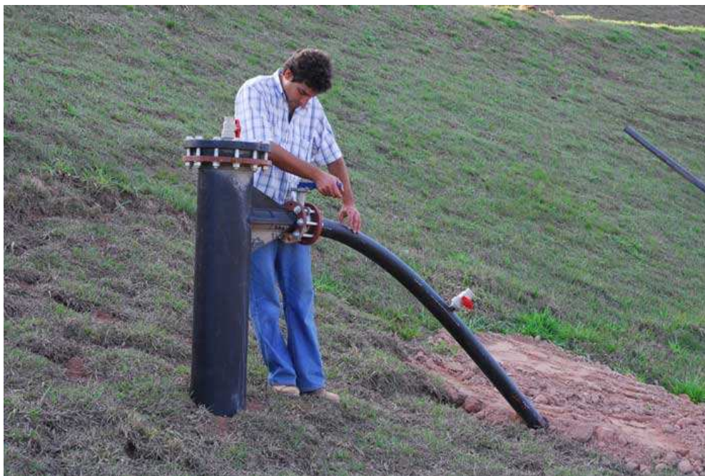
Figura 43 Vista de cabeçote instalado no Aterro Sanitário CDR-Pedreira.
