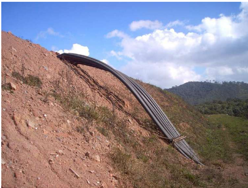
Figura 26 Vista de linhas em talude com zona de respiração.
