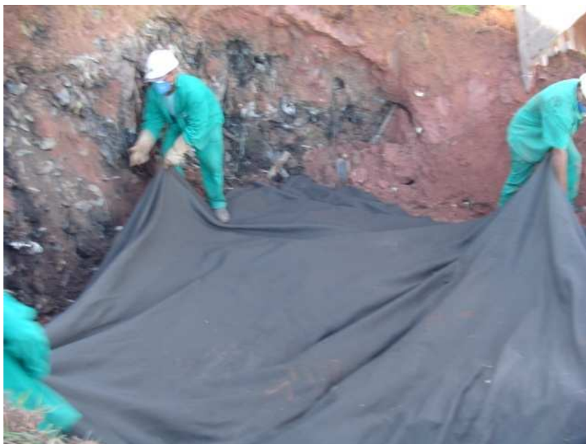
Figura 35 Vista de instalação de Manta Geotextil.
