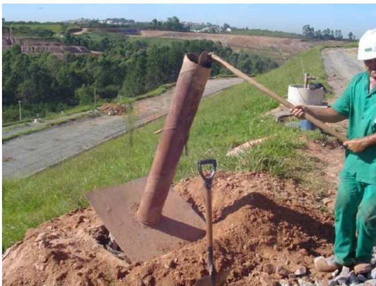
Figura 30 Vista de Encerramento de fogo em Dreno Vertical por abafamento.
