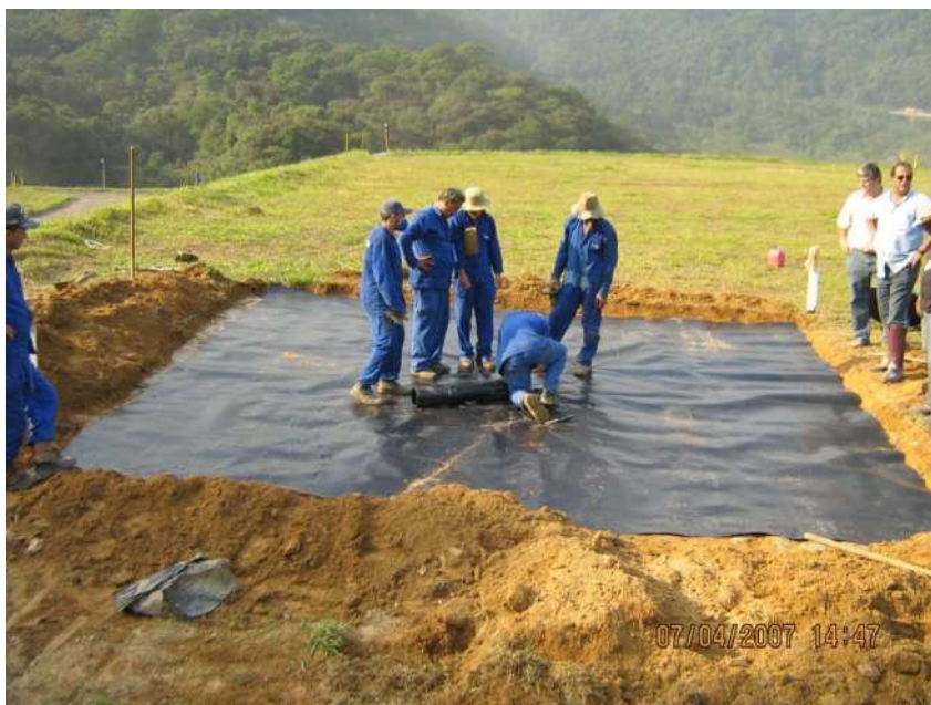
Figura 38 Vista de instalação de Manta PEAD em platô no Aterro Terrestre.
